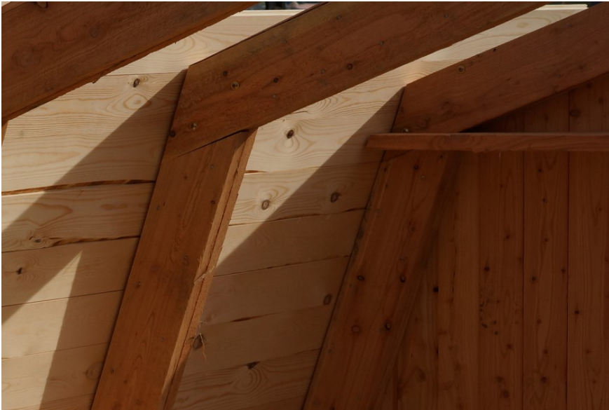
Billede af hylde og spær samling Foto: Lone Himmelstrup
