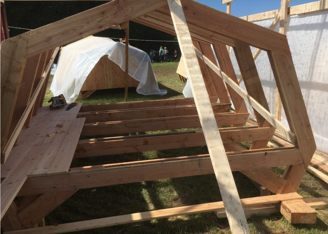
Spærene er rejst og der er startet på gulvet.
